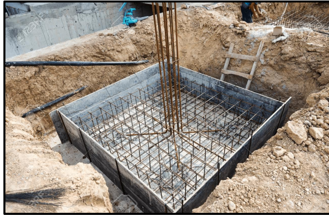
Gambar 2.1 Pondasi Telapak
