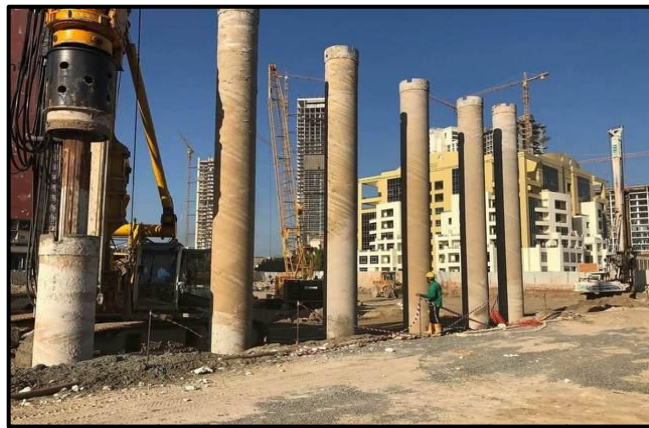
Gambar 2.5 Pondasi Tiang Pancang
