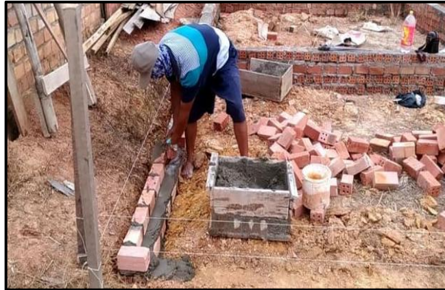
Gambar 2.3 Pondasi Batu Bata ( Rollag )
