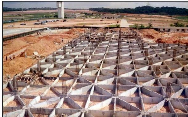
**Gambar 2. 6** Pondasi Konstruksi Sarang Laba-Laba
