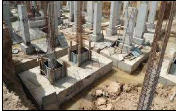
Gambar 2. 3 Pondasi Telapak
