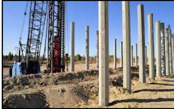
Gambar 2. 8 Pondasi Tiang Pancang
