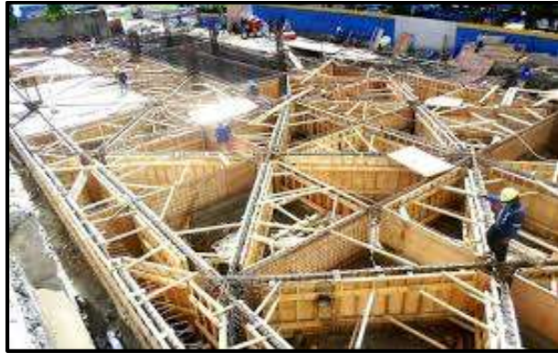
Gambar 2. 5 Pondasi Konstruksi Sarang Laba-Laba
