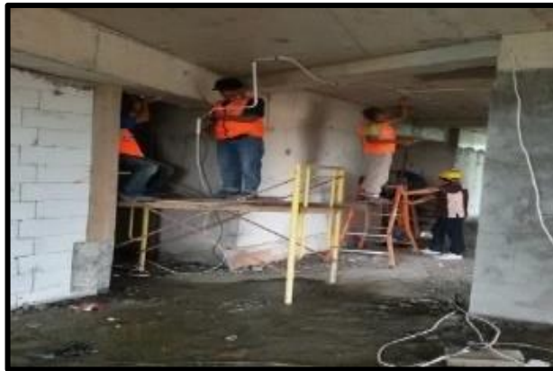
Gambar 2.25. Gambar Pemasangan instalasi listrik rumah risha
