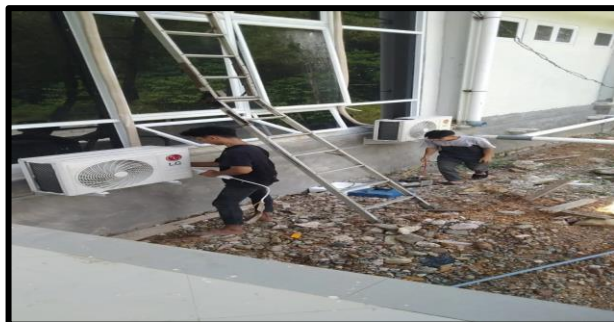
Gambar 2.24. Gambar pemasangan mekanikal rumah risha Sumber: https://siopen.hulusungaiselatankab.go.id/
