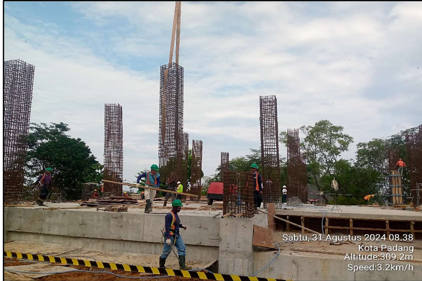
Gambar 2.20 Pemasangan Tulangan dan Pemasangan Bekisting
