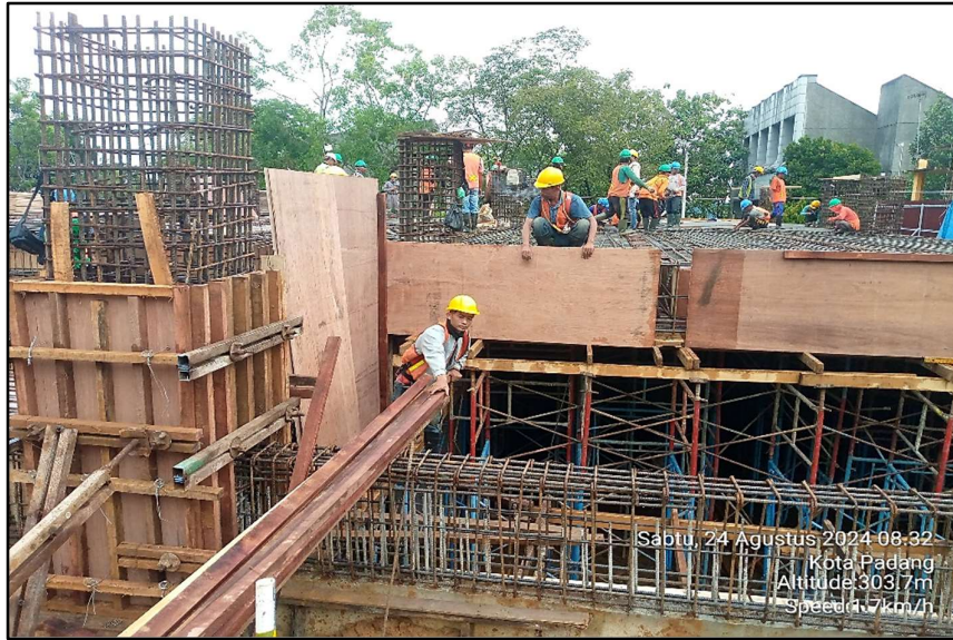
Gambar 2.21 Pemasangan Bekisting Pada Balok dan Pelat Lantai
