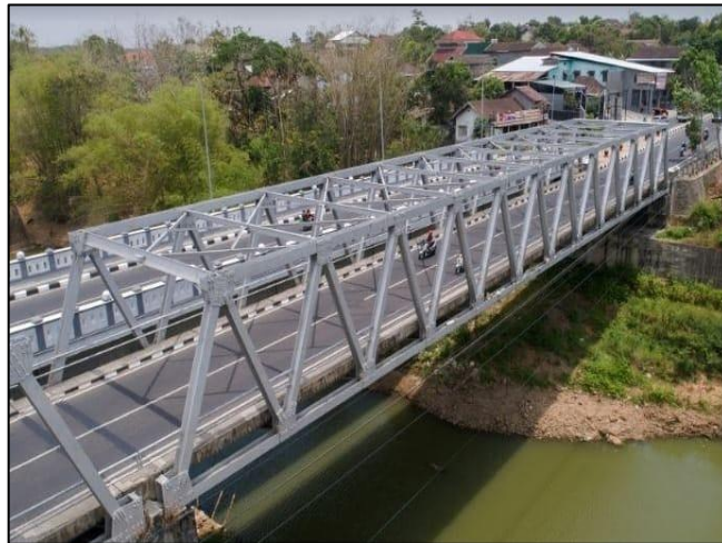
Gambar 2. 1 Jembatan Rangka Baja
