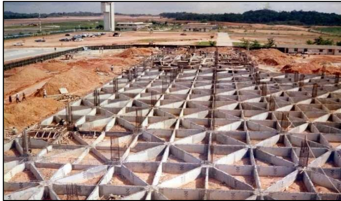
Gambar 2. 14 Pondasi Konstruksi Sarang Laba-laba
