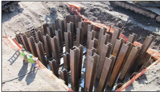
Gambar 2. 28 Tiang pancang baja
