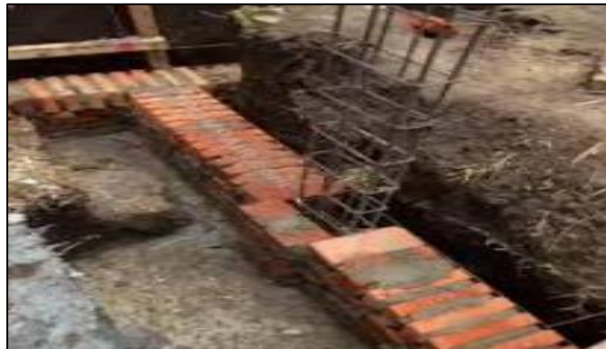
Gambar 2. 5 Pondasi Batu Bata ( Rollag )
