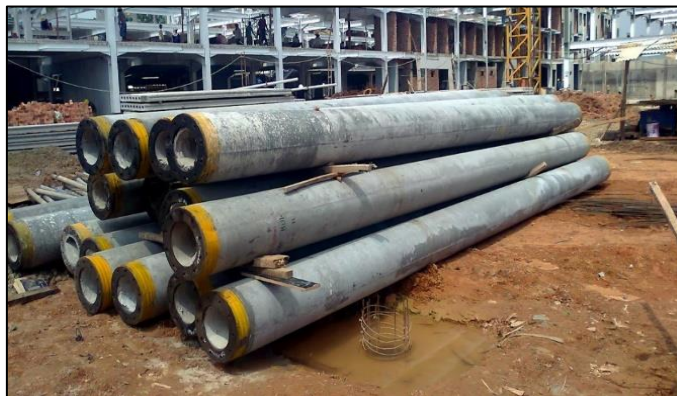
Gambar 2. 27 Tiang Beton Pracetak
