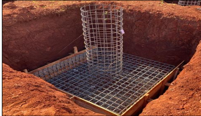
Gambar 2. 8 Pondasi Telapak
