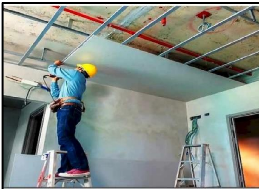
Gambar 2.9 Contoh Pekerjaan Pemasangan Plafon
