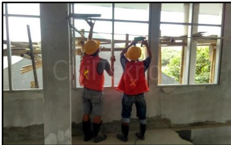
Gambar 2.7 Contoh Pekerjaan Pemasangan Pintu dan Jendela
