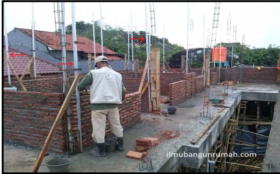
Gambar 2.6 Contoh Pekerjaan Pemasangan Dinding Bata
