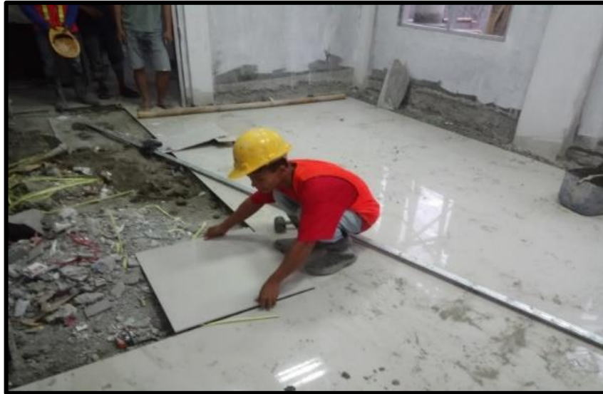
Gambar 2.8 Contoh Pekerjaan Pemasangan Lantai
