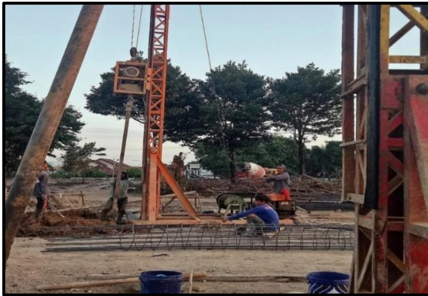
Gambar 2.4 Contoh Pekerjaan Pondasi Borepile
