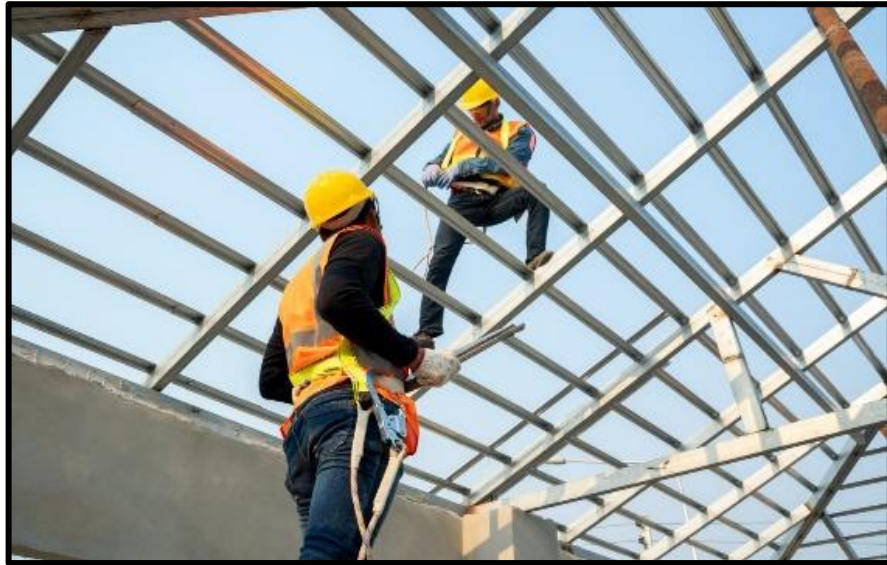
Gambar 2.10 Contoh Pekerjaan Pemasangan Atap
