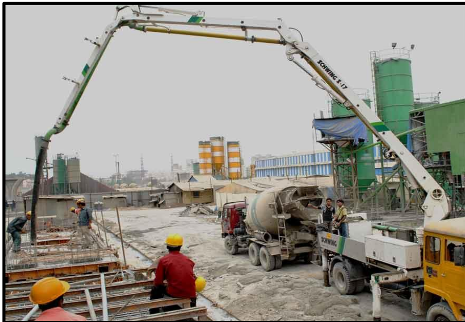
Gambar 2.5 Contoh Pekerjaan Struktur
